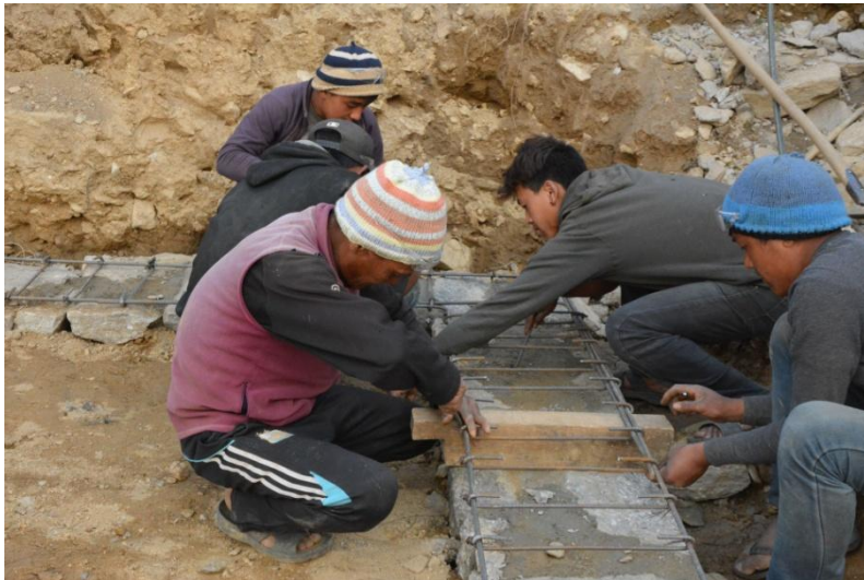
Die Eisenhaken müssen exakt platziert werden.
