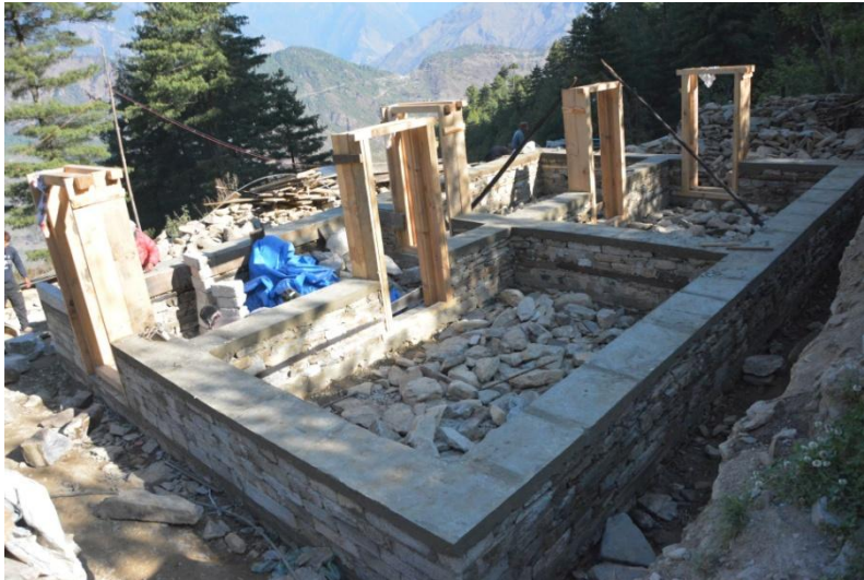
Die Türen sind gesetzt
