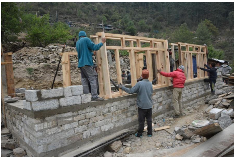
Baufortschritt in Brabal - Fenstereinbau
