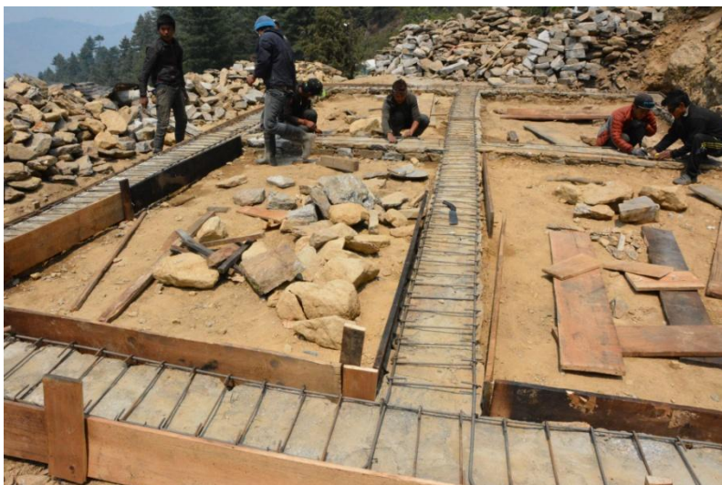
Holzschalung für das erste seismische Betonband
