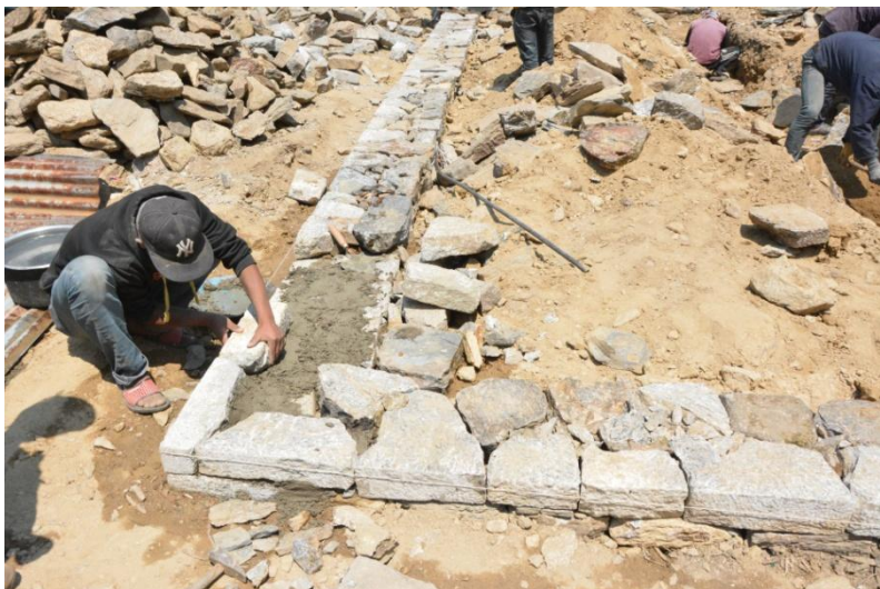
Fundament des ersten Muster-Hauses in Brabal
