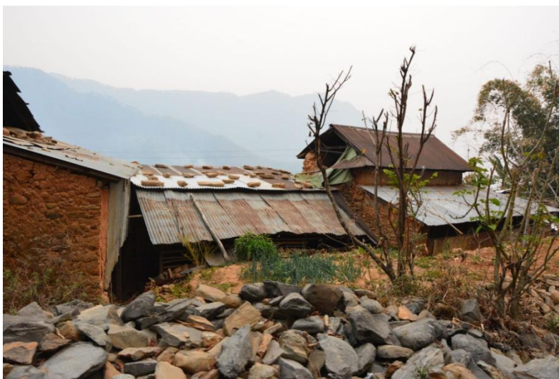
Zerstörte Häuser provisorisch mit Wellblech repariert
